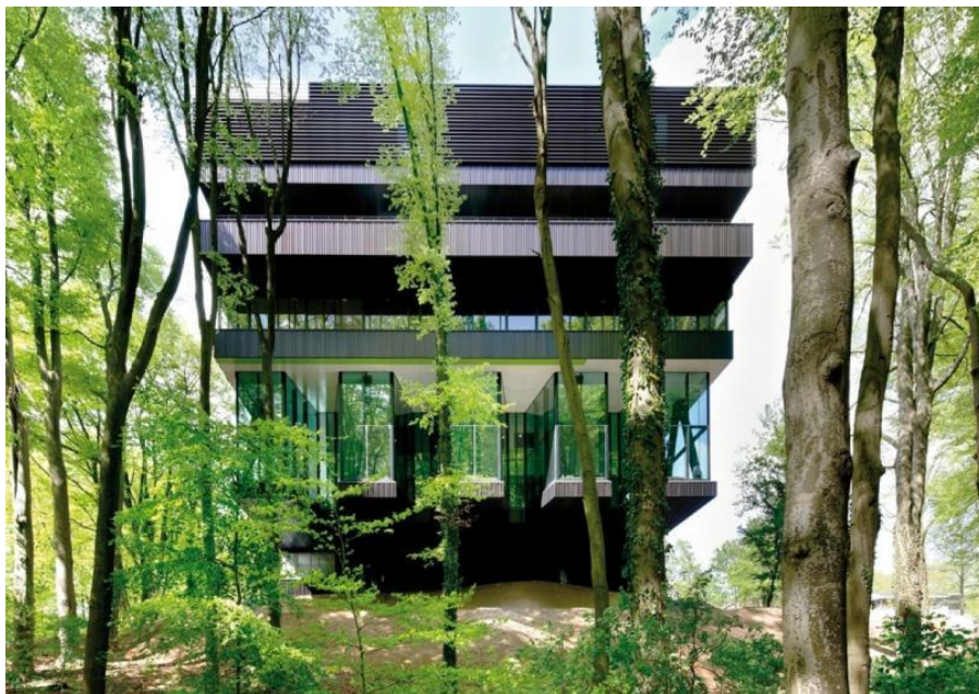
Fig 4.7: Rehabilitation Groot Klimmendaal
