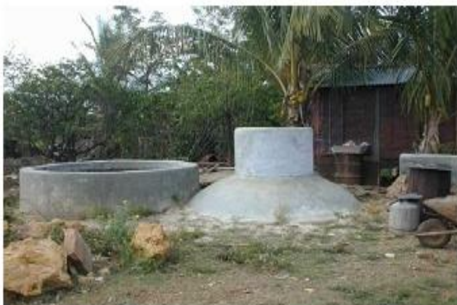
Figura-1.15 - Biodigestor de Cúpula Fixa
