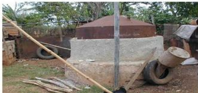
Figura-1.14 Biodigestor de sino Flutuante,(lizandra, 2014)
